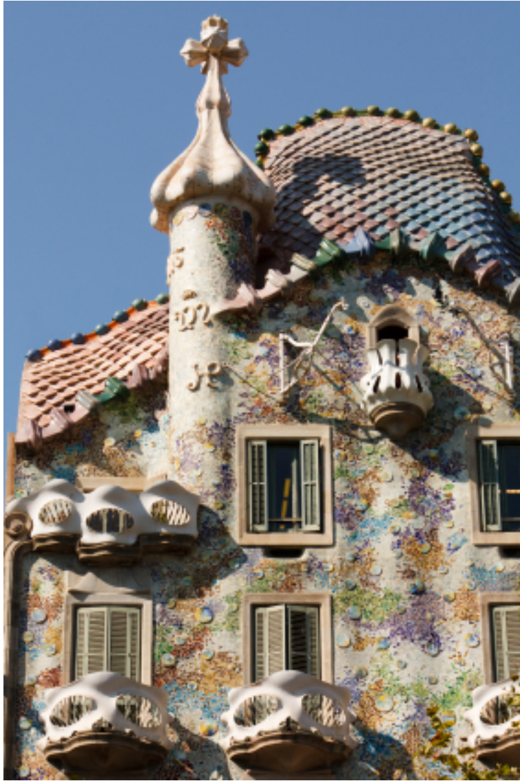
Figure 6. Antoni Gaudí's Casa Batlló , Barcelona.
