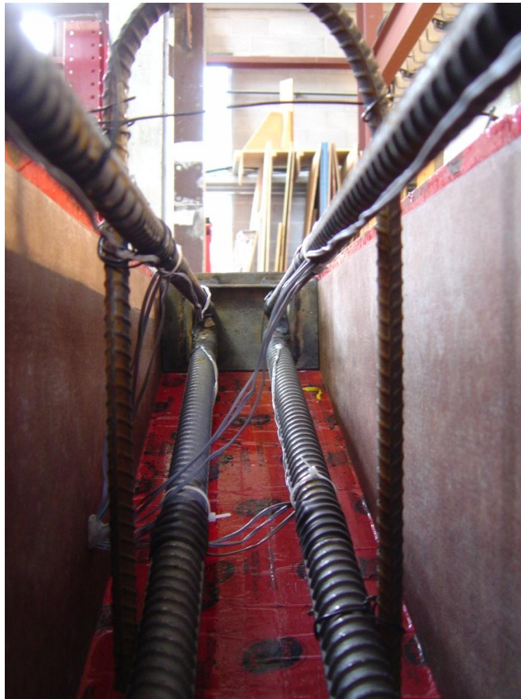
Figure 4.46 – ECB-TS-RA1 prior to concrete pour
