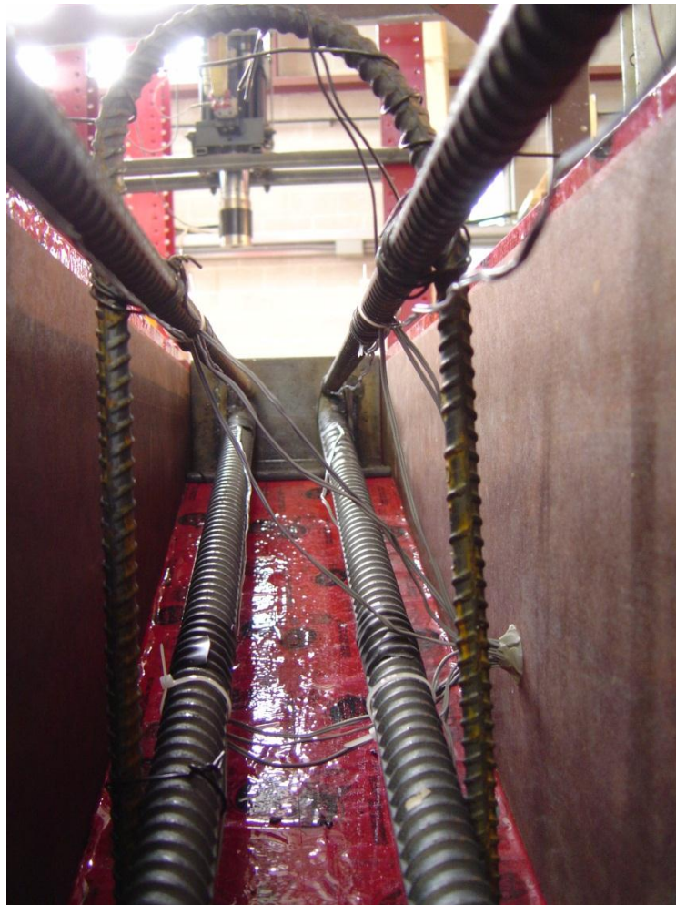
Figure 4.44 – ECB-TS1 prior to concrete pour
